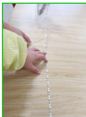
Se possível, a fita deverá ser aplicada por duas pessoas em simultâneo de forma a assegurar o correto percurso da fita e remoção da fita adesiva.
